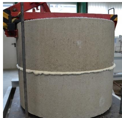
Abbildung 2: Aufsetzen des oberen Schachtrings und Herstellung der Verbindung
