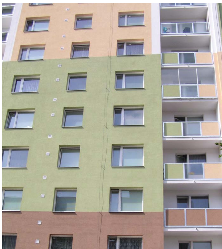
Rekonstruovaný panelový dům, Svitavy
