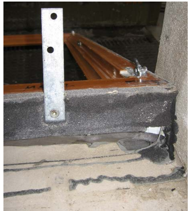
Bilder 6 und 7 Wannenförmige Ausbildung der TwinAktiv-Folie unter der Fensterbank, Ausbau des Fensters, Ausführung der Eckausbildung, der Befestigung und Lastabtragung im Brüstungsbereich, sowie der ergänzenden Abdichtung im Eck- und Brüstungsbereich mit illbruck PU25
