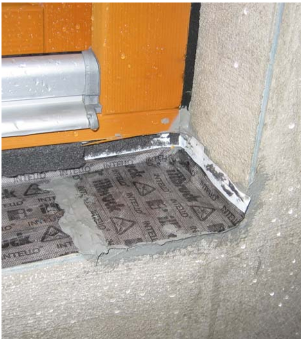
Bilder 6 und 7 Wannenförmige Ausbildung der TwinAktiv-Folie unter der Fensterbank, Ausbau des Fensters, Ausführung der Eckausbildung, der Befestigung und Lastabtragung im Brüstungsbereich, sowie der ergänzenden Abdichtung im Eck- und Brüstungsbereich mit illbruck PU25
